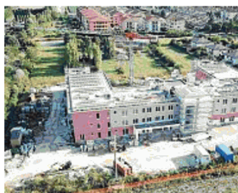
In costruzione Una delle nuove Residenze assistenziali sanitarie della friulana Sereni Orizzonti
